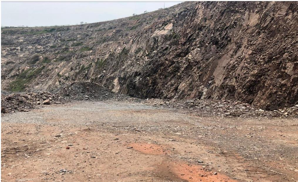
Figura 25 - Remoção dos escombros após detonação no Bloco 33-21
